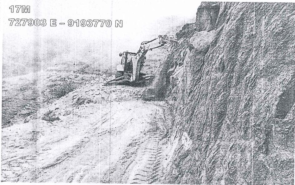
FOTOGRAFIA N°06: Perfilado de taludes en puntos críticos.
