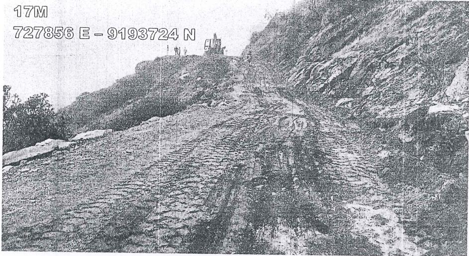
FOTOGRAFIA N°05: Perfilado de la superficie de rodadura en puntos críticos.
