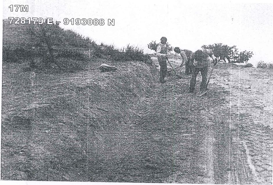
FOTOGRAFIA N°08: Reconformación de cunetas.
